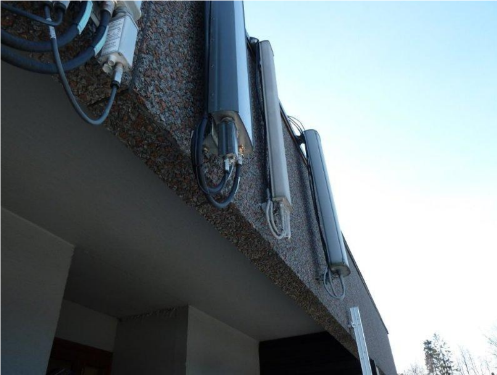
Foto 2: Bildet viser fra venstre LTE 800 (ikke satt i drift), LTE 2600, UMTS 2100 og GSM 900.
