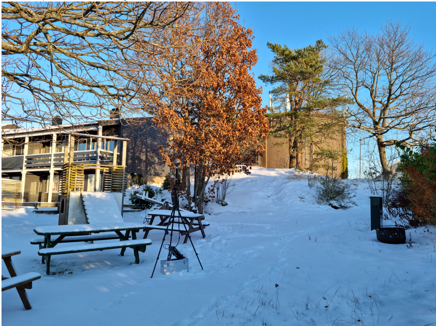
Bilde 1 Antenner på vanntårn i bakgrunnen Antenner på vanntårn i bakgrunnen
