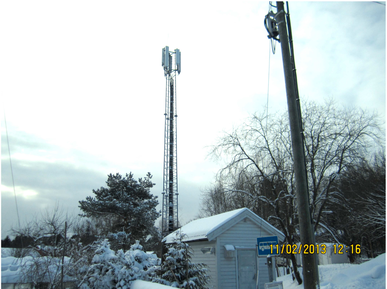
Nylig oppsatt basestasjon i nærheten av Omveien 2 på Haugenesfeltet ved Fevik. Pos N 58° 23' 7.44" E 8° 42' 2.57"
