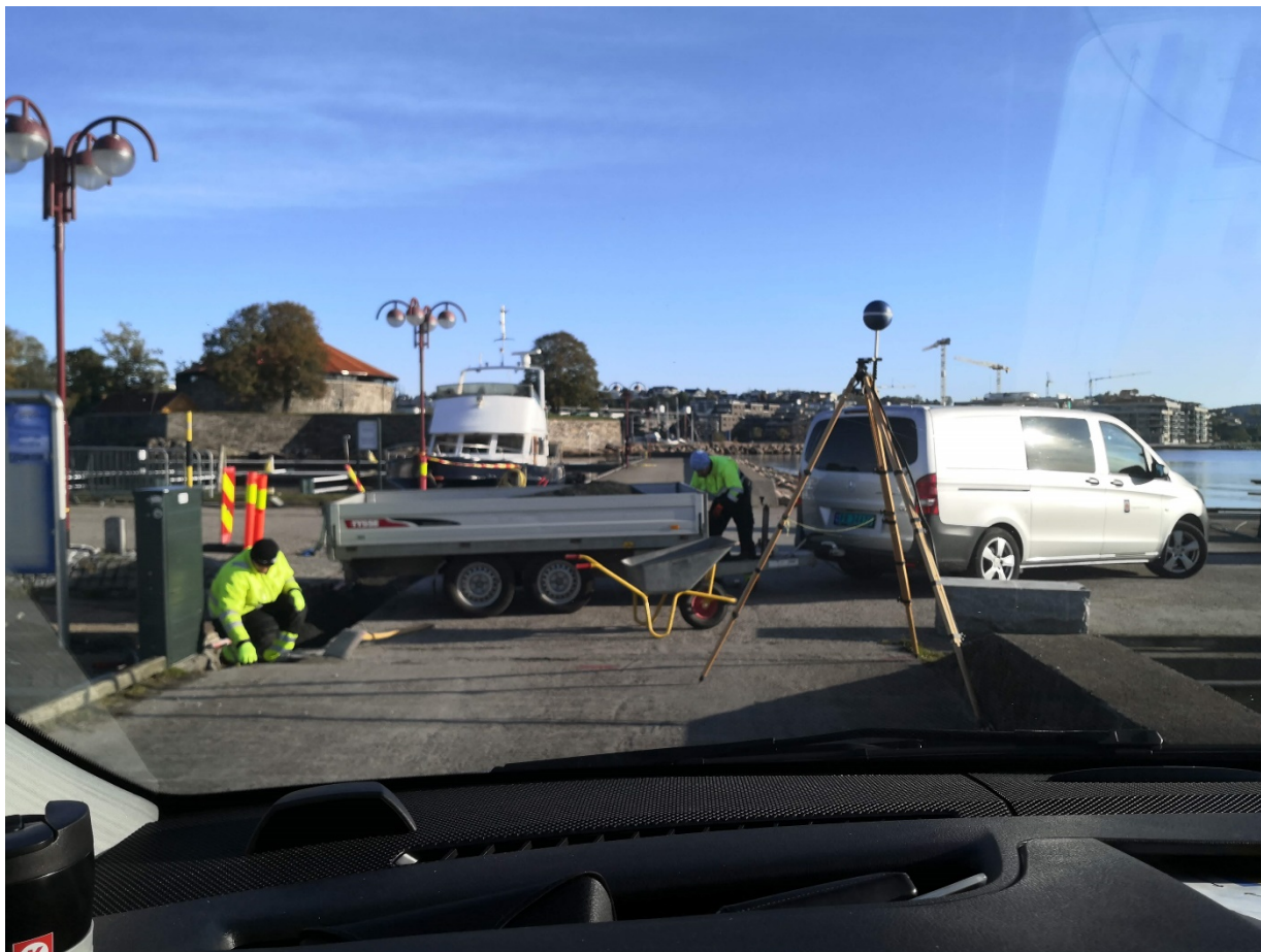
Figur 4. Anleggsarbeid ved et målepunkt. Metallkonstruksjoner nært inntil antennen kan potensielt forstyrre målingene. Foto: Atle Coward Markussen, Nkom.
