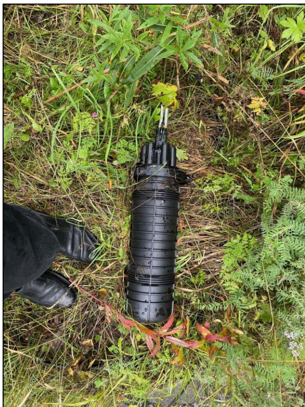
Figur 15: Mellombels reparasjon i Buskerud med skøytebombe (skøyteboks) liggande på bakken og knuste fiberrør i bekken. Foto: Nkom
