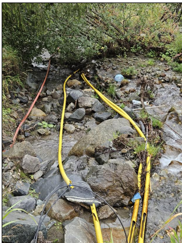
Figur 15: Mellombels reparasjon i Buskerud med skøytebombe (skøyteboks) liggande på bakken og knuste fiberrør i bekken. Foto: Nkom
