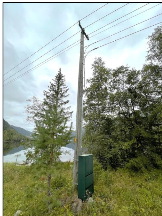
Figur 26a og b: Døme på god merking i terrenget og godt utført overgang for fiberkabel frå luft til jord til sjø i Buskerud. Foto: Nkom
