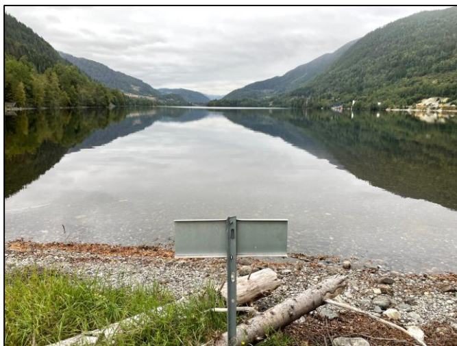
Figur 26a og b: Døme på god merking i terrenget og godt utført overgang for fiberkabel frå luft til jord til sjø i Buskerud. Foto: Nkom
