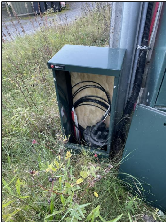
Figur 21: Ulåst kabelskap
