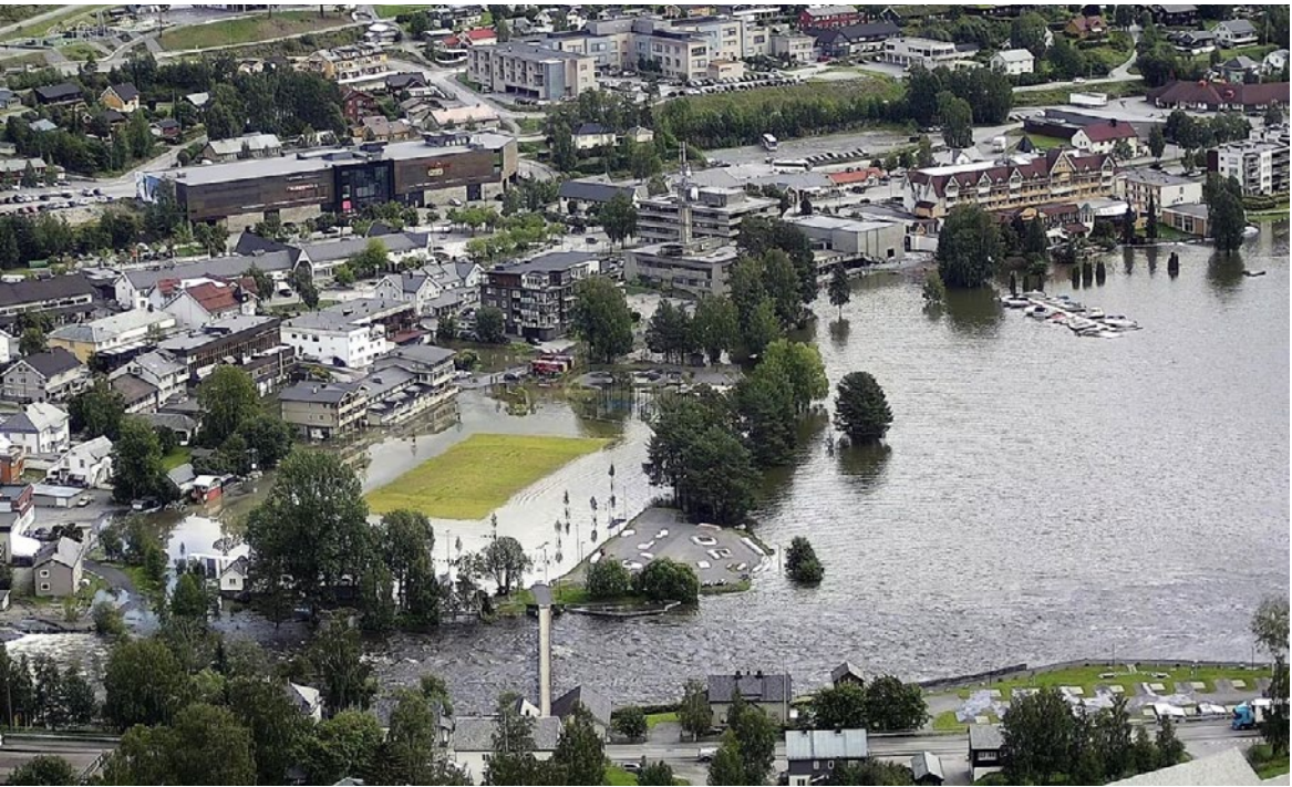
Oversiktsbilete frå Fagernes sentrum under ekstremværet Hans, tatt 11.08.23. Ekominfrastruktur var svært nærme å bli overfløymt på grunn av høg vassføring i vassdraget.
