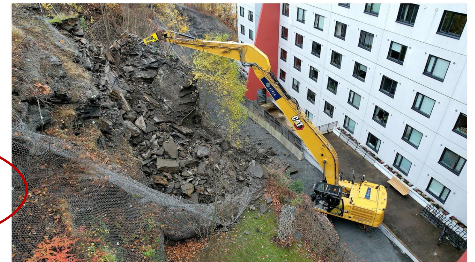
SIKRER ETTER RAS: Fjernstyrt langgraver med pigghammer løsner stein for stein for å sikre området etter raset i Oslo.
