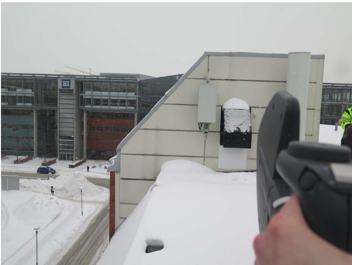
Figur 3 Basestasjon sett fra målepunkt 1
