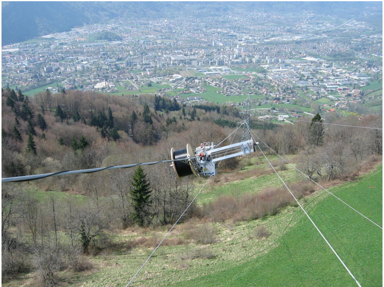
Figur 6 Spinnefiber (Optical attached cable, OPAC) på eksisterende høyspenttrasé (Kilde: Wikipedia)
